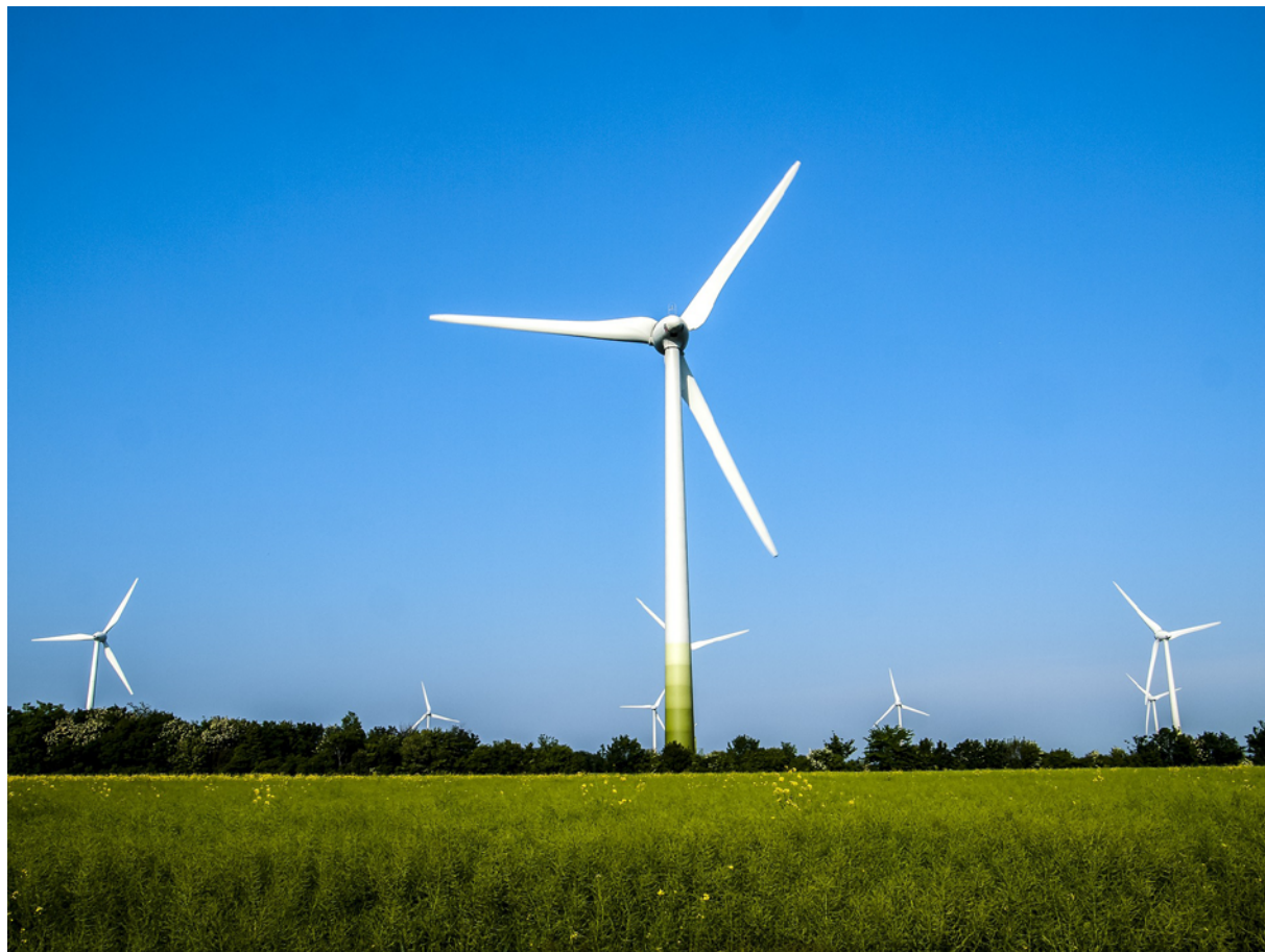
FOTOGRAFÍA 8. Acción o medida para hacerse cargo del impacto ambiental en el valor paisajístico: pintura de color en la base de la torre el aerogenerador
