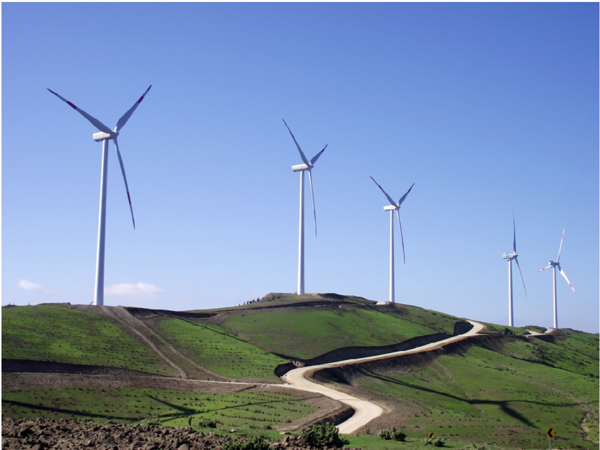
FOTOGRAFÍA 7. Parque eólico en el sur de Chile
