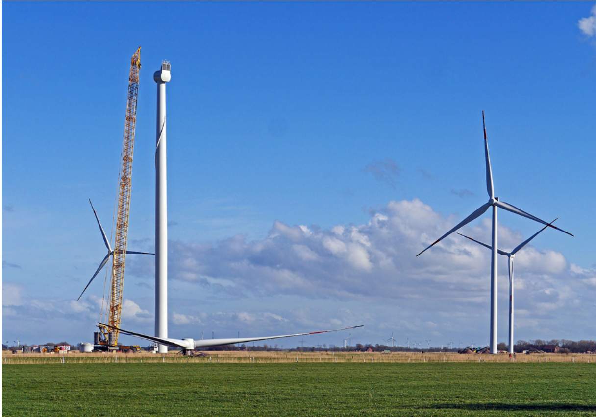
FOTOGRAFÍA 6. Ejemplo de montaje del rotor con las aspas de un aerogenerador
