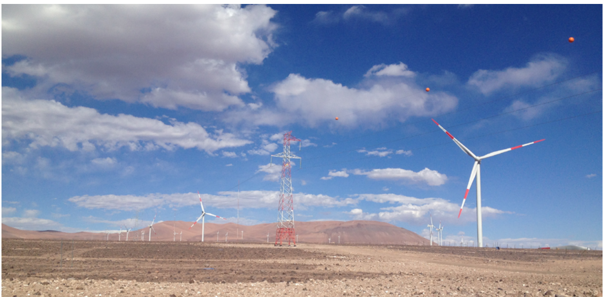
FOTOGRAFÍA 1. Central eólica desarrollada en tierra, ubicada en la comuna de Taltal, Región de Antofagasta
