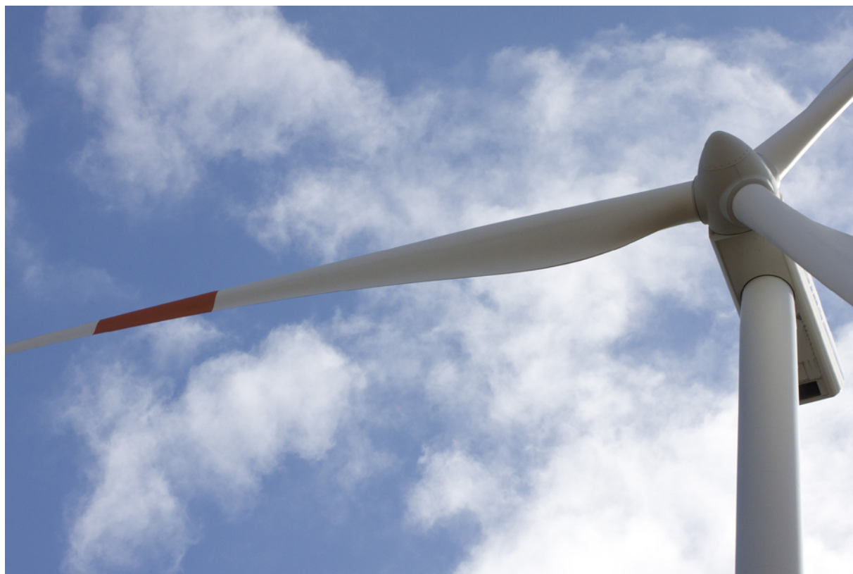
FOTOGRAFÍA 3. Aspas, rotor, góndola y parte de la torre de un aerogenerador
