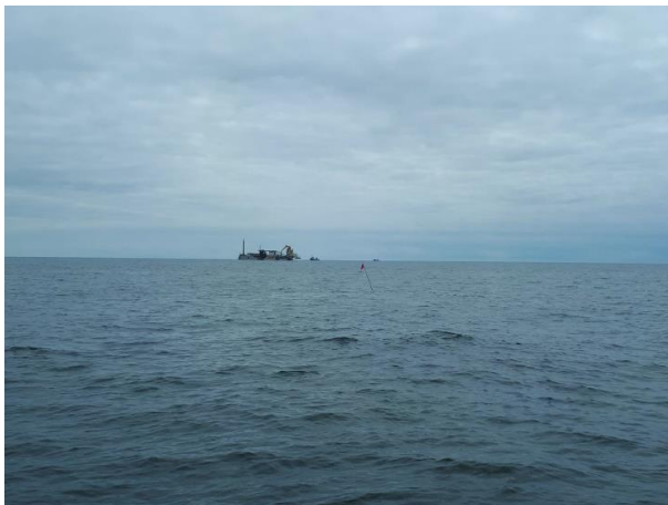
Filage de casiers à proximité de travaux de préparation de sol (juillet 2021)
