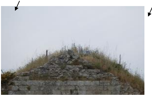
Figure 3 : emplacement de la station d'enregistrement de l'île du Pilier (source : Etienne Ouvrard, LPO Vendée) ; sur la photo de droite, on voit les dégradations du microphone par les goélands ; les flèches indiquent l'emplacement de la station d'enregistrement
