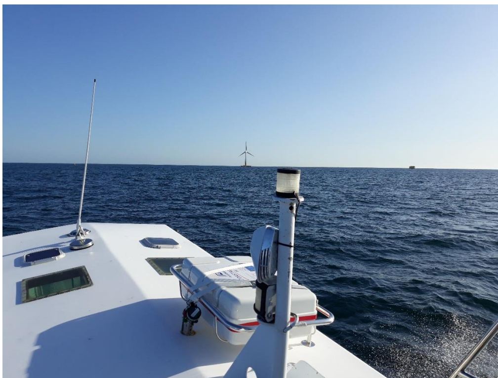
Figure 2 – Vue sur l'éolienne flottante du site SEM-REV depuis le poste d'observation de la plateforme de l'OVNI (octobre 2019)
